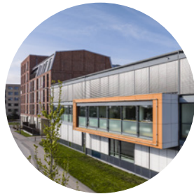
Amager Strandvej 60 Copenhagen S
