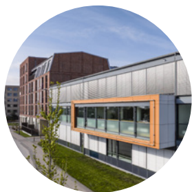
Amager Strandvej 60 Copenhagen S
